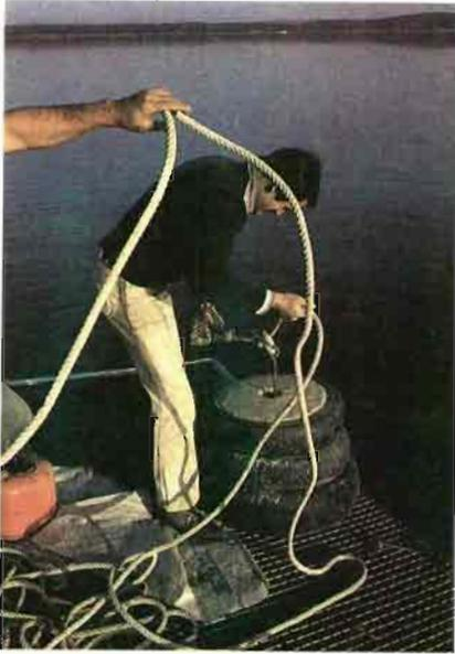
Fig. 8.—Lastre o «muerto» para el anclaje de las jaulas.
